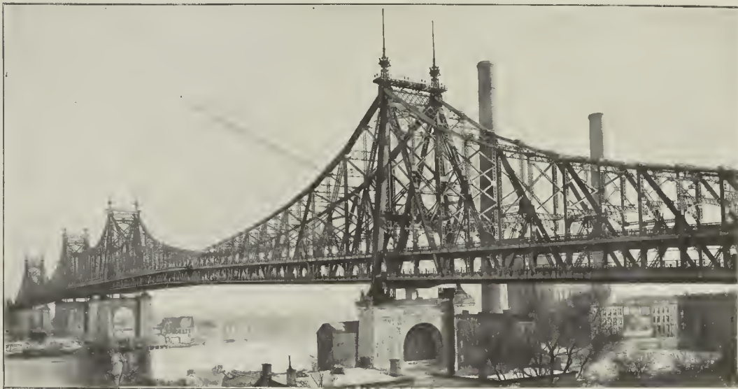
Vista general del puente
